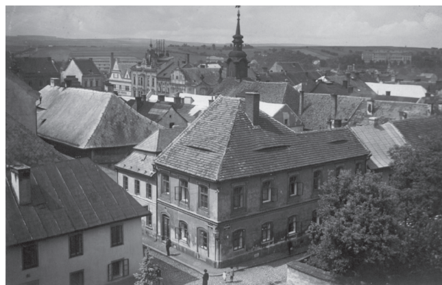
V domě JUDr. Meisla čp. 7 v Rybičkově ulici je dnes budova B Okresního soudu Chrudim – kancelář opatrovnícká, exekuční a dědická
